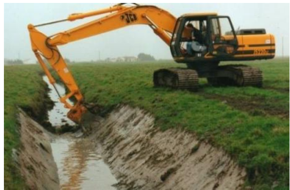
Figure 7 : Exemples de curage et reprofilage de fossés
